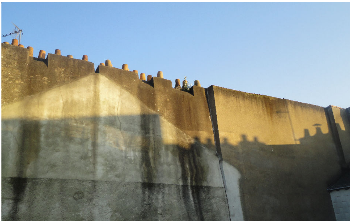
Demolition d'un immeuble . 2
